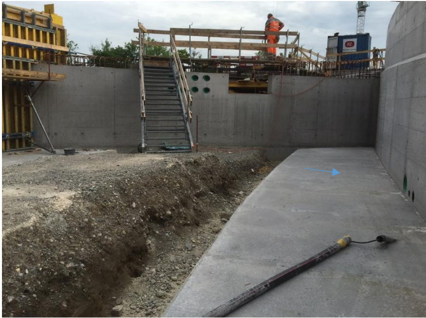
Abbildung 3: Lage der Bohr- kern- ent- nah- me- st- ellen bei der Stütz- mauer Ost, Seite West
