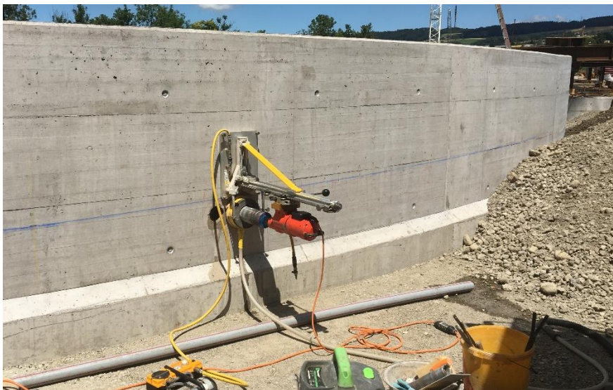
Abbil- dung 4: Lage der Bohr- kern- ent- nah- me- st- ellen bei der Flügel- wand West, Seite Süd
